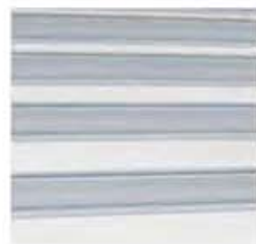
施工後の屋根(遮熱塗装後)
