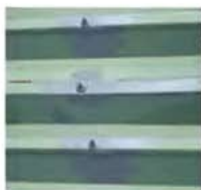
施工前の屋根(遮熱塗装前)
