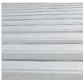
施工前の屋根(遮熱塗装前)
