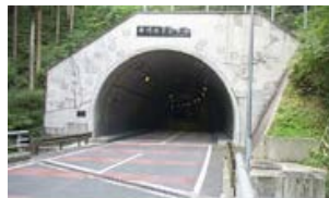
● 天川村新川合トンネル
