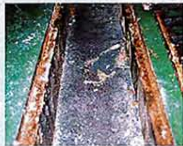
マーベルトラフ施工前
