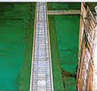
マーベルトラフ施工後
